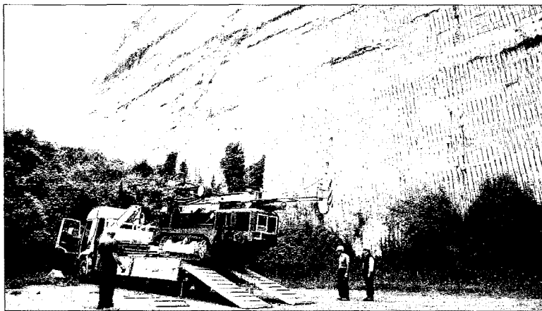
I lavori alla cava di Chiaiano dove sarà allestita la discarica della città di Napoli
