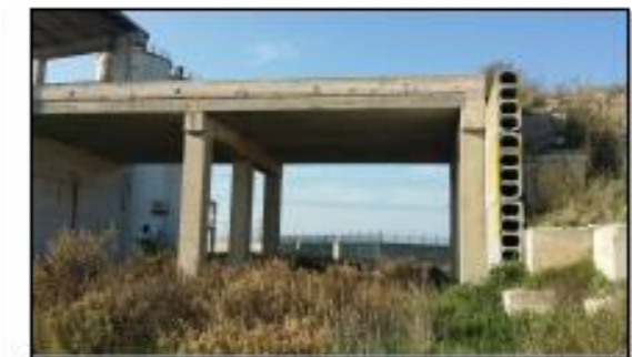
FOTO 10 - Area esterna capannone
