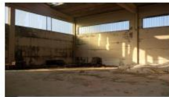
FOTO 11 - Area interna capannone
