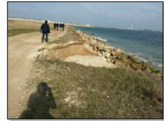
FOTO 8 - Strada lungomare e scogliera di protezione
